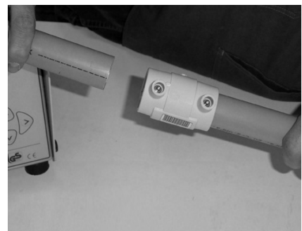
6. Надвинуть муфту на трубу до отметки
