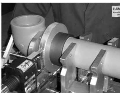
Рис. 9 Сдвинуть каретку при помощи рукоятки, нагреть трубу и фитинг на сварочных насадках
