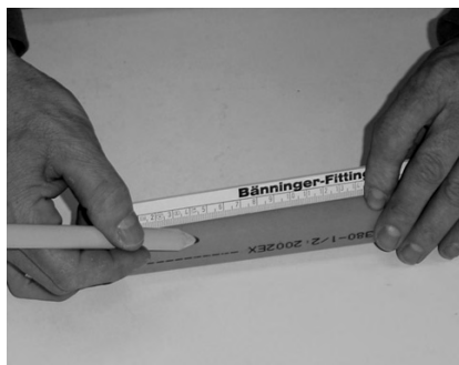
5. Отметить на трубе глубину посадки муфты
