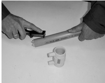
2. Наружный оксидный слой удалить с помощью щетки
