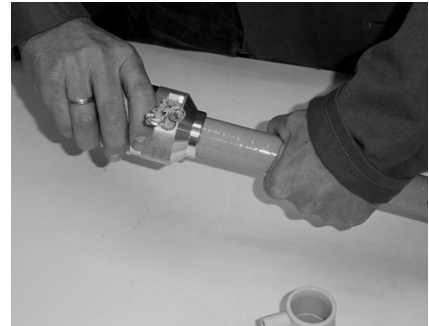
3. С трубы-штаби счистить перед сваркой алюминиевое покрытие
